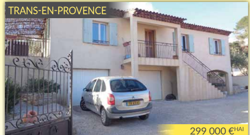
TRANS-EN-PROVENCE Sur un terrain de 675 m 2 -VILLA CONSTRUCTION TRADITIONNELLE composée: -RDC:garage+cave -RDJ:Séjour/cuisine américaine équipée 52 m 2 -3 chambres-Sdbains- EXCELLENT ETAT GENERAL réf4090 comm.acheteur 3,01%
