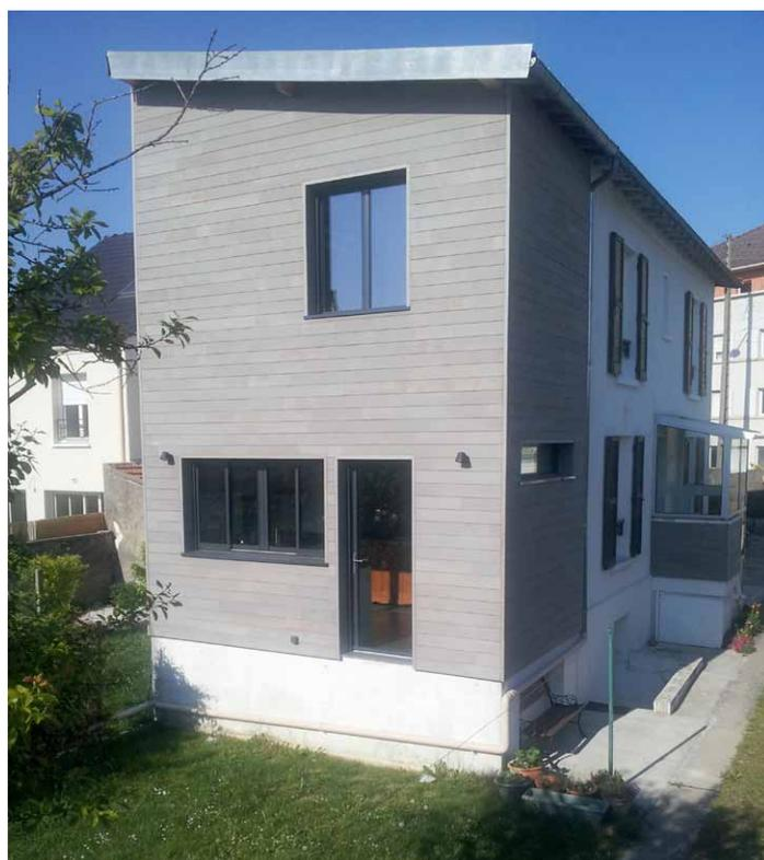
L'extension bois est souvent posée sur une dalle béton donc les travaux de terrassement / maçonnerie sont à réaliser en premier lieu. Il est parfois possible de réaliser un plancher bois ; intéressant en particulier si le sol de l'extension est surélevé par rapport au sol naturel. Il faut compter 2 semaines environ pour ces travaux.
